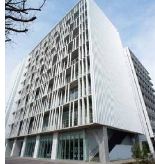
湘南キャンパス Techno Cube (19号館)
